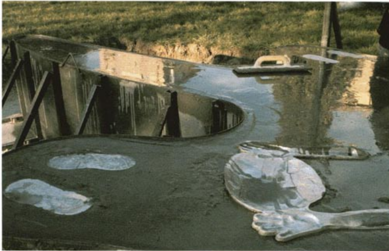
Una fase del cantiere di Totipotent Architecture durante la posa delle impronte nel cemento
